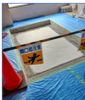
工事現場画像
